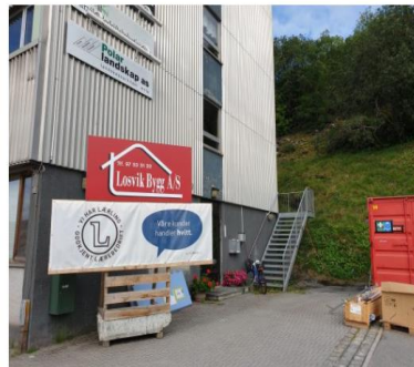
Her er fra en av byggeplassene til Lovvik Bygg AS på Norvik Havn. Her har tømrerlærlingen Håkon Larsen blant annet holdt på med bygging av to nye heiser.
